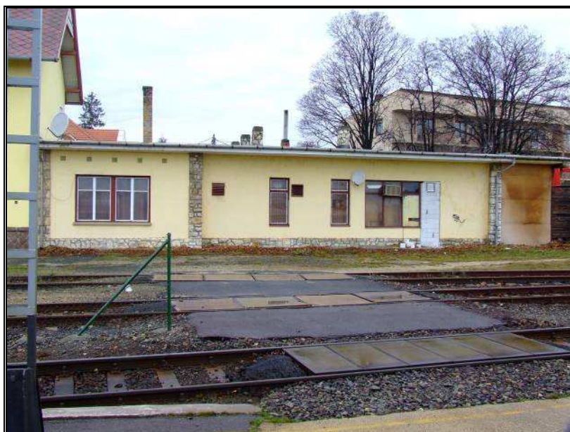
37. ábra: A szintbeli átjárók a legritkább esetben tekinthetők valóban akadálymentesnek (Balatonfüred)
